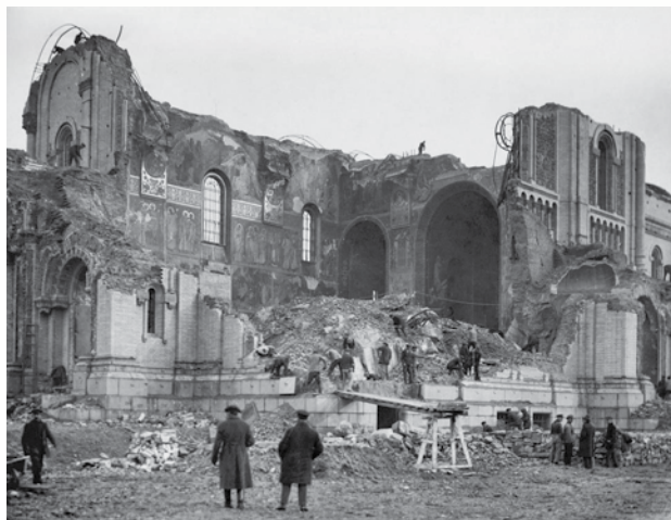
Rozbiórka soboru na pl. Saskim, widok od ul. Królewskiej. 8 marca 1926 r. Źródło: Architektura.muratorplus.pl
