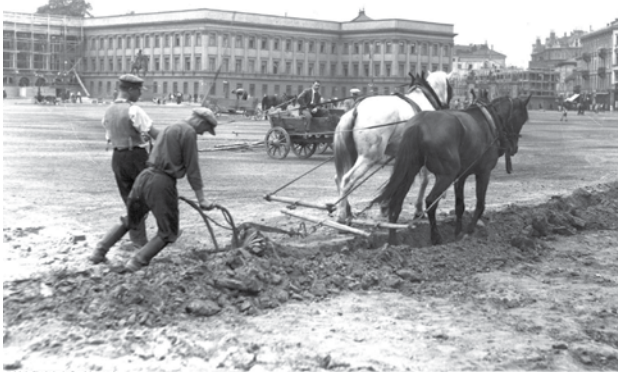
Po rozebraniu soboru robotnicy za pomocą pługa usuwają starą nawierzchnię placu Saskiego. Źródło: Polska-org.pl
