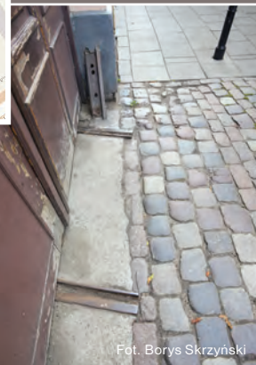
W bramie budynku przy ul. Inżynierskiej 6 pozostał tor tramwajowy o przedwojennym, szerokim rozstawie
