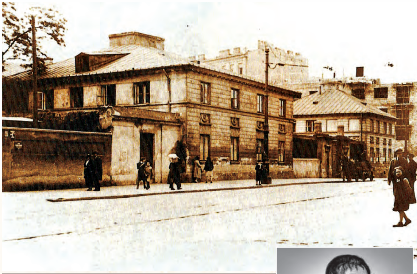
Budynek Pałacu Bogusławskiego, róg Żytniej i Żelaznej – obecnie siedziba zakonu Zgromadzenia Sióstr Franciszkanek Rodziny Maryi. Zdjęcie z okresu międzywojennego; po wojnie budynki odbudowano w prawie niezmienionym kształcie (Źródło: www.warszawa1939.pl ).
